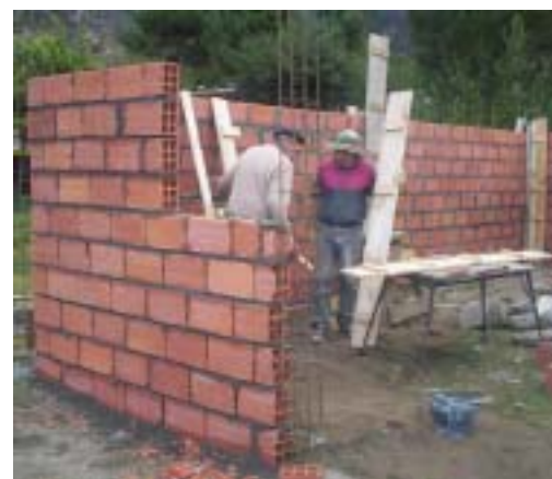
Construyendo la sala de informática, don José Vargas y don Segundo Arebol
