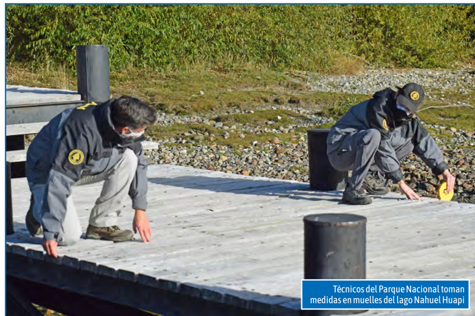
Relevamiento de muelles sobre el lago Nahuel Huapi
