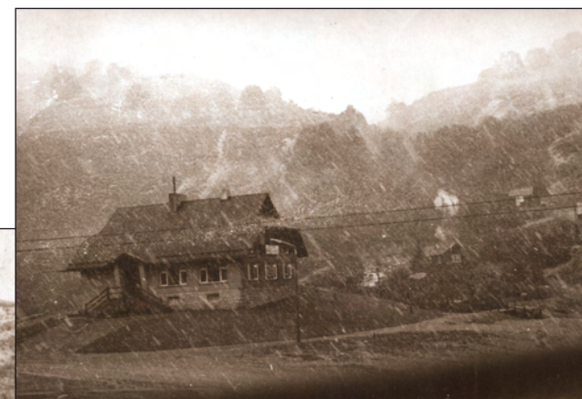
Antiguo edificio Hostería Pire Hue
